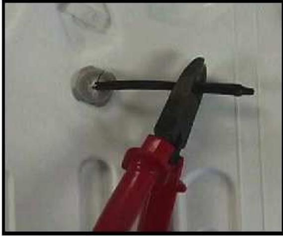
2) Separe los cables del gabinete. Pele la funda para ver los dos cables de ser necesario.
